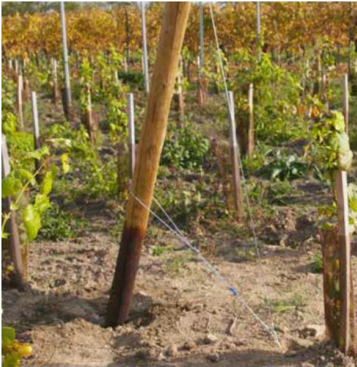
Haubanage d'un piquet bois à l'aide d'un GPAK Plus W
